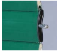
· Catenacciolo di sicurezza incassato a diverse altezze
