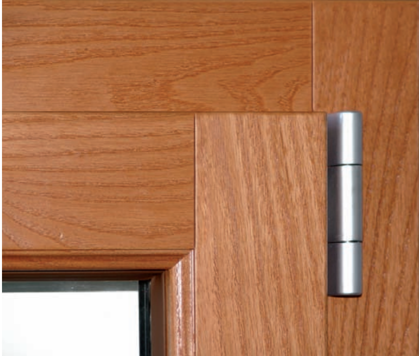
Particolare assemblaggio superiore con taglio a 90°.
